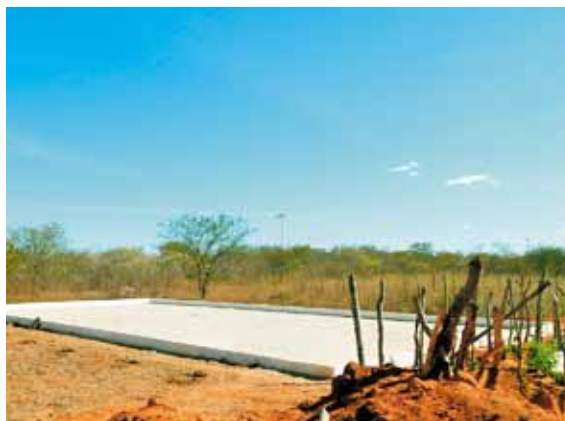
Figura 12: Cisterna calçadão construída no assentamento Professor Maurício de Oliveira, em Assu, RN
