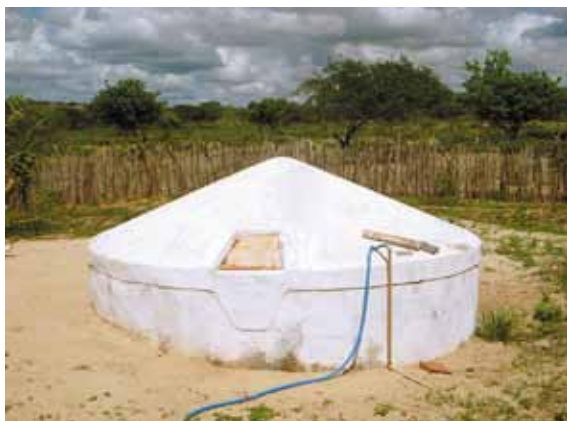
Figura 11: Cisterna de placas construída no assentamento Irmã Dorothy, Carnaubais, RN
