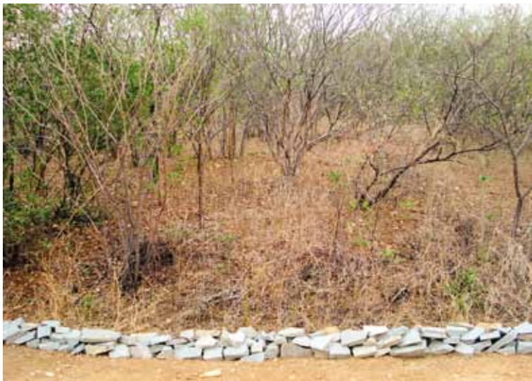
Figura 12: Renques construídos para barrar o processo de erosão do solo
