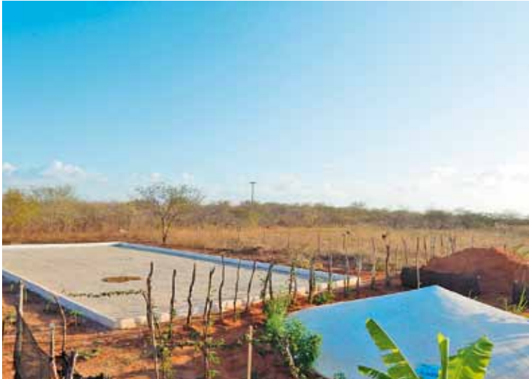
Figura 13: Armazenamento de água em cisterna calçada
