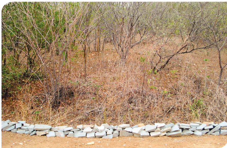
Figura 15 – Renques construídos para barrar o processo de erosão do solo. Fonte: Elisângelo Fernandes da Silva (2013).
