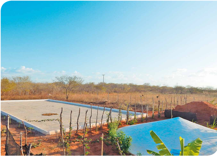
Figura 13 - Armazenamento de água em cisterna calçadão.
